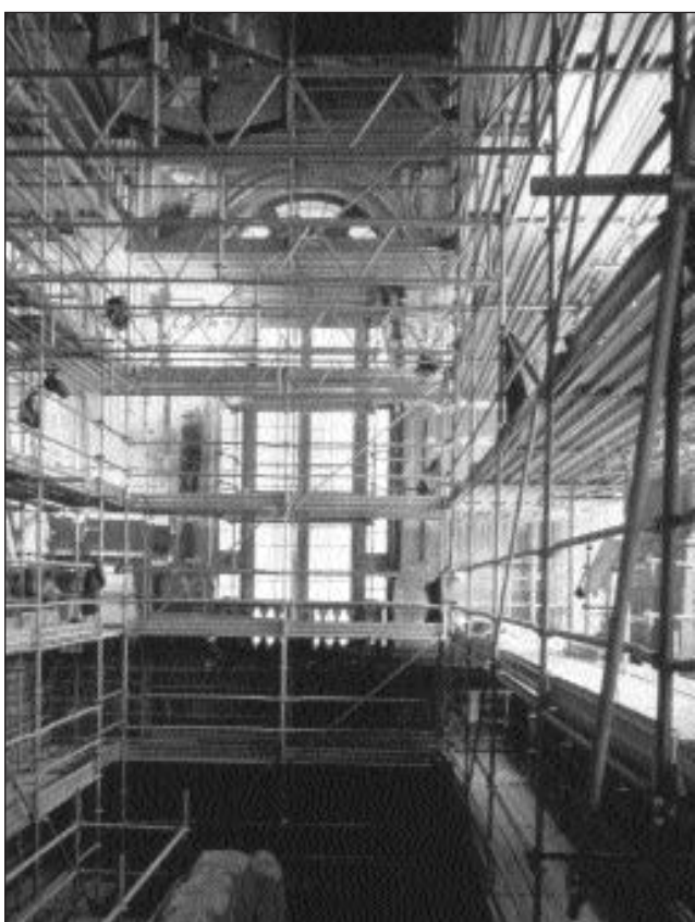
Il cantiere di restauro dell'avancorpo juvarriano di Palazzo Madama, progetto promosso dalla Città di Torino in collaborazione con la Fondazione Crt, foto Bruna Biamino
